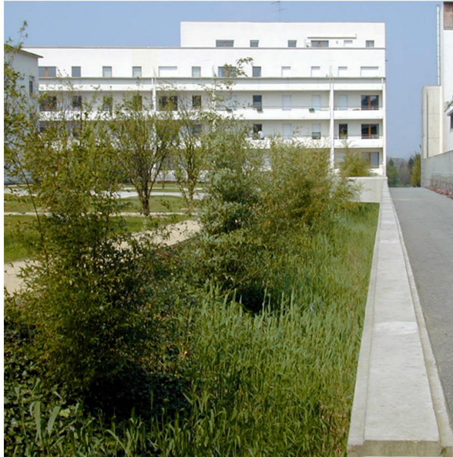
Voie partagée accompagnée d'une noue paysagère Quartier de la Morinais, Saint Jacques de La lande (35) - Agence Bruei Delmar
