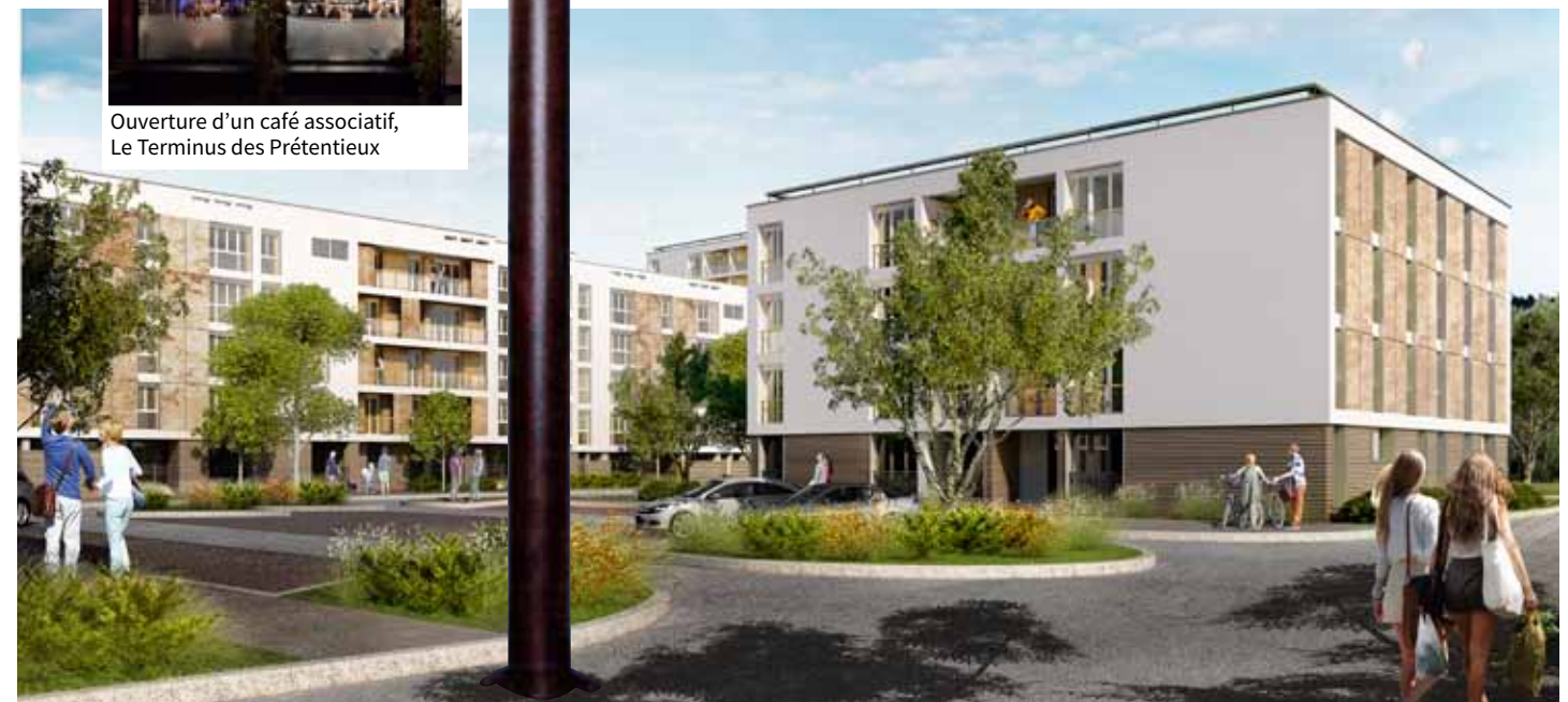
Rénovation des façades du Mont Valier
