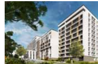
Rénovation des logements du Vicdessos
