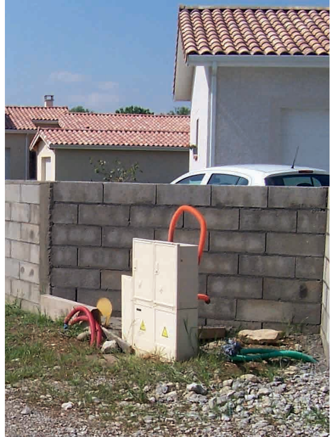
Le SDEHG réalise le raccordement au réseau des nouvelles habitations en commune rurale.
