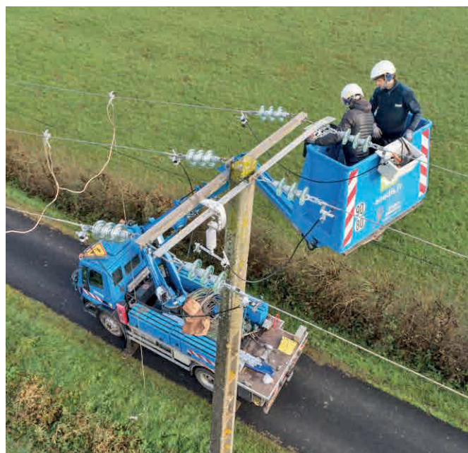
Les équipes d'Enedis réalisent la maintenance du réseau électrique moyenne tension.
