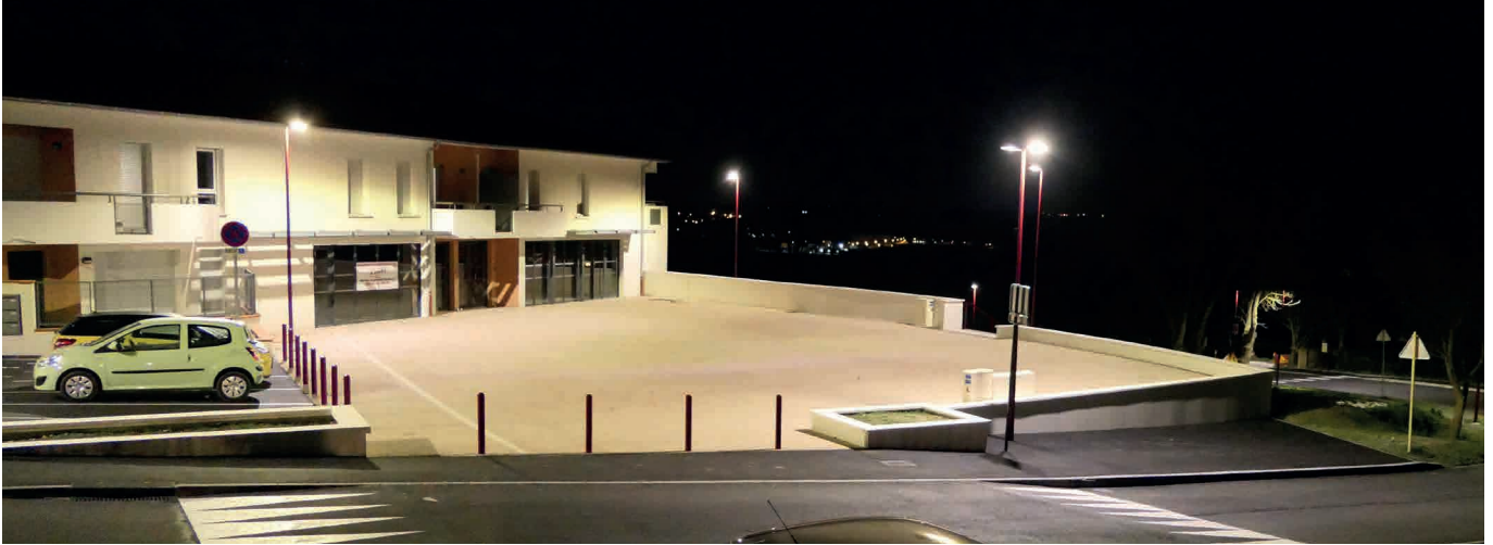
L'éclairage public de la nouvelle place du Belvédère à Aigrefeuille, réalisé par le SDEHG, dispose de luminaires économes en énergie et respectueux de l'environnement avec un flux lumineux homogène et dirigé vers le sol.
