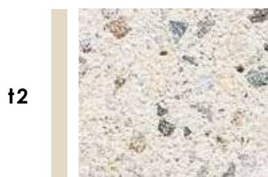
Trottoir : béton bouchardé
